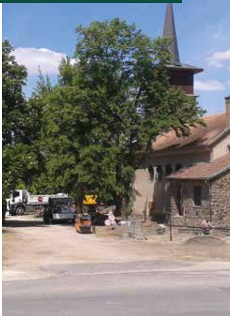
A templomtér munkálatai
