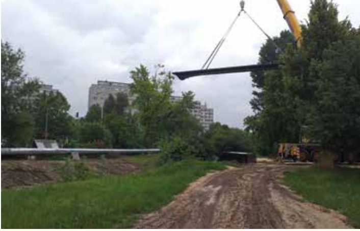
Hatalmas daru emelte be helyére a hídelemet
